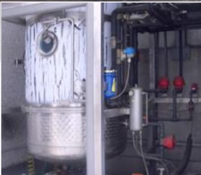
Complesso impianto di aerazione e depurazione dell'acqua derivati dalle lavorazioni, dal bagno galvanico e residui.
